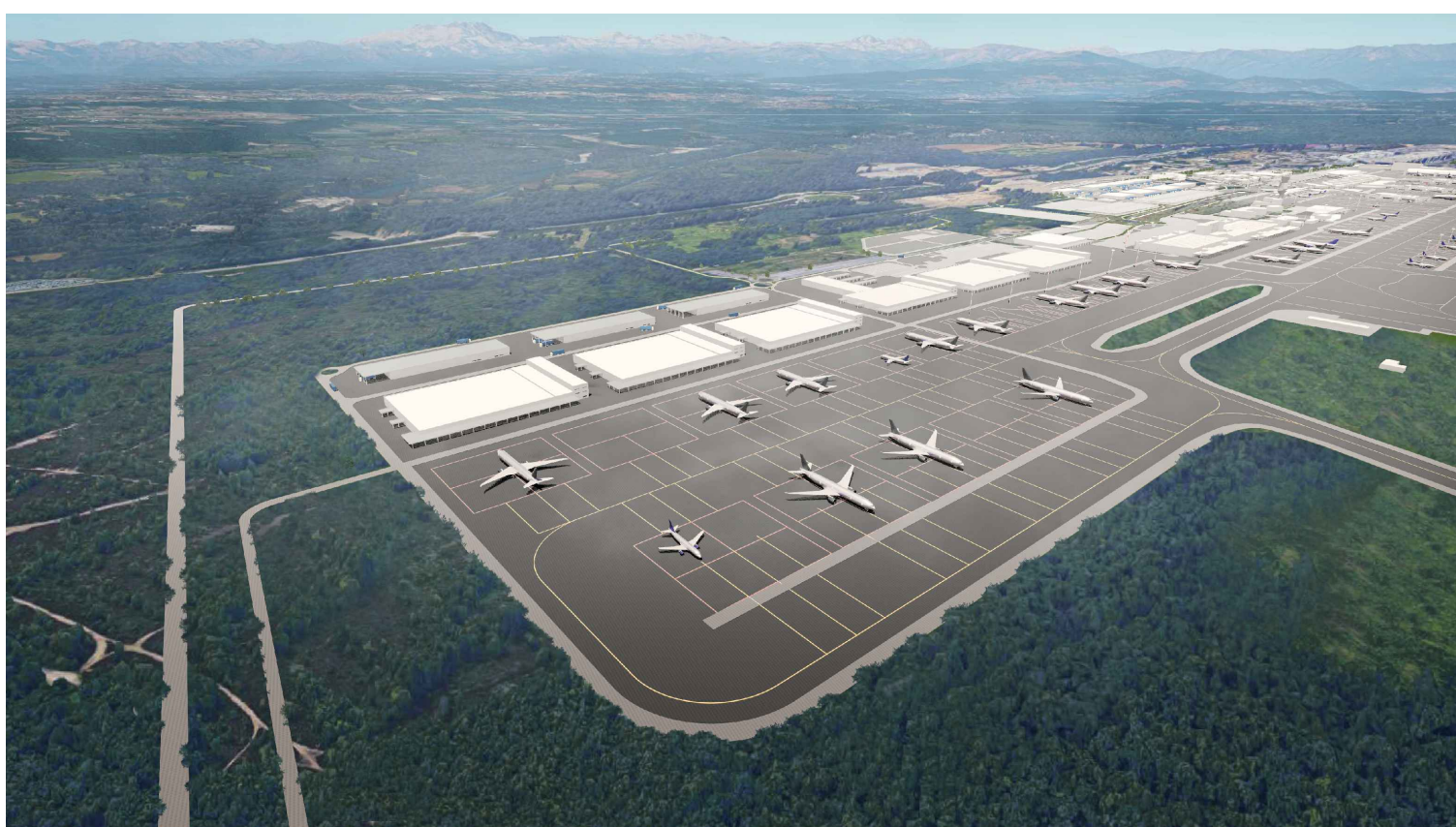
03 VISTA DELL'AREA CARGO PRIMA LINEA
