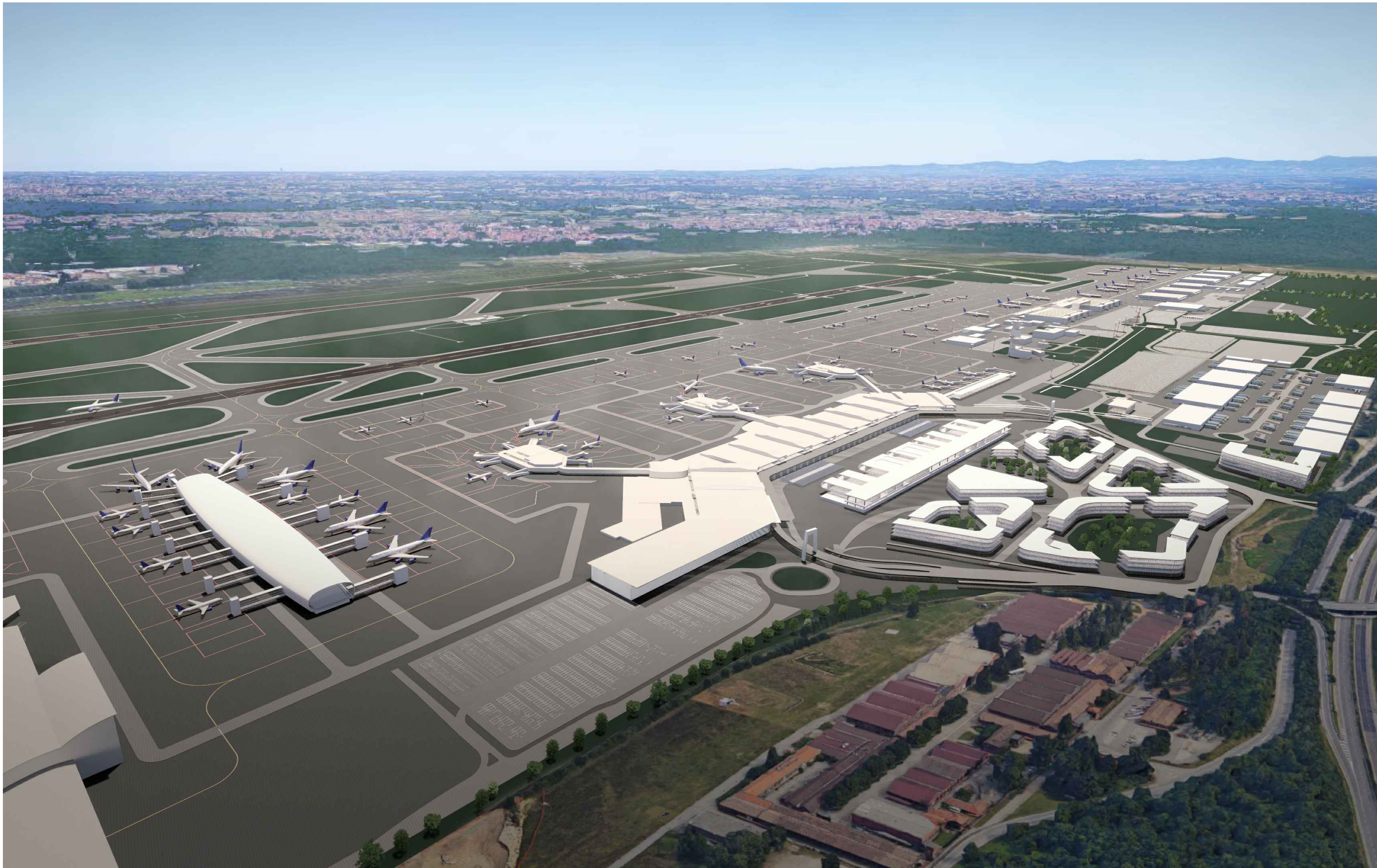
02 VISTA DEL TERMINAL 1 E DEL QUARTO SATELLITE
